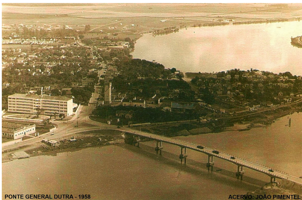
Figura 3: Ponte General Dutra – 1958. Fonte: Acervo João Pimentel.
