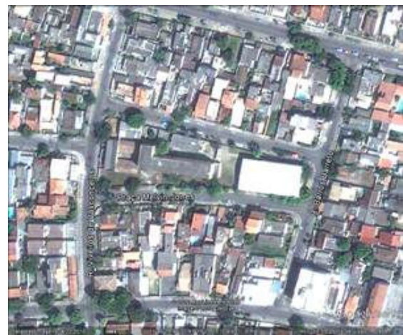
Figura 5 – Edificação construída na praça
