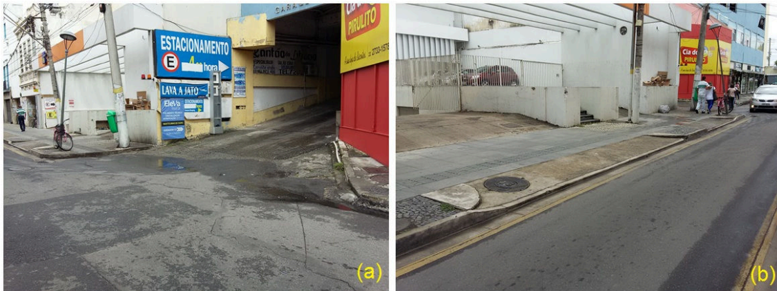
Figura 9. Interrupção de calçada (a) e continuidade de calçada (b) na Zona Centro Histórica de Campos dos Goytacazes, RJ.
