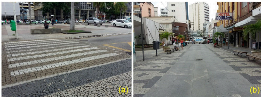
Figura 3. Piso elevado na Praça São Salvador (a), e calçadão na Avenida 7 de Setembro (b) na Zona Centro Histórica de Campos dos Goytacazes, RJ.
