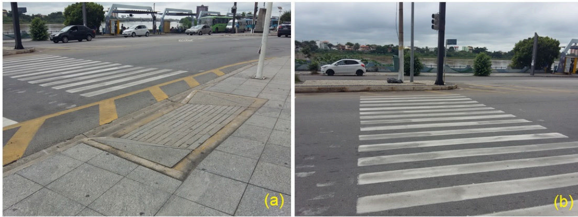
Figura 4. Rampa de acessibilidade e faixa de pedestre (a), e local sem rampa (b) na Zona Centro Histórica de Campos dos Goytacazes, RJ.
