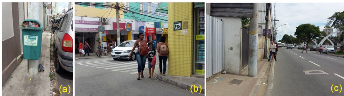
Figura 5. Calçada estreita com poste e lixeira (a), esquina com calçada estreita (b), e muro avançando sobre a calçada (c) na Zona Centro Histórica de Campos dos Goytacazes, RJ.
