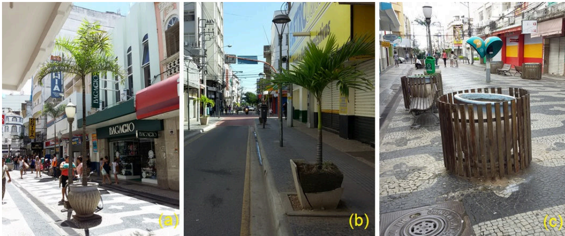
Figura 11. Vasos para arborização na Zona Centro Histórica em Campos dos Goytacazes, RJ(a); fragilidade dos vasos(b); Ausência de plantas(c).
