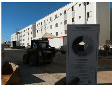
Figura 1: Canteiro de Obra.
