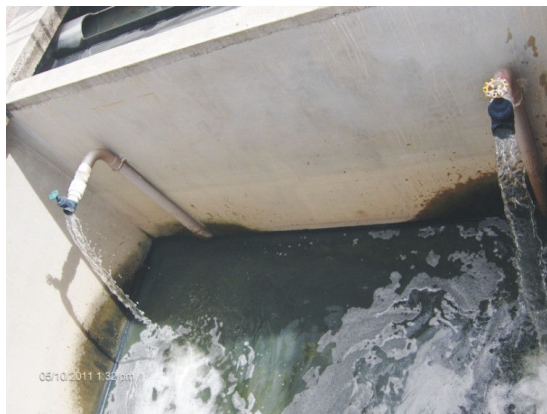
Figura 8: Ponto de coleta do efluente (saída)
