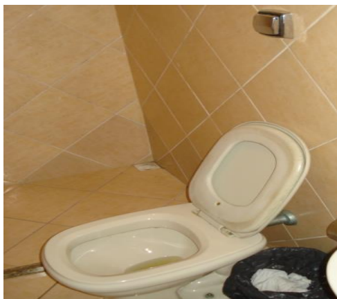
Figura 3: Vaso Sanitário com válvula do Banheiro dos Professores (Térreo)
