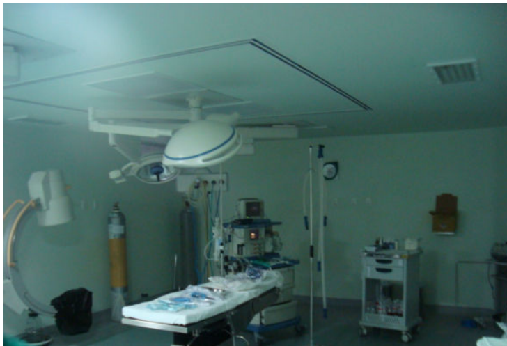
Foto 3: Sala de cirurgia com refrigeração central pelo difusor do estilo capela.
